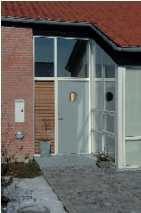
Niveaufri adgang via rampe med repos
