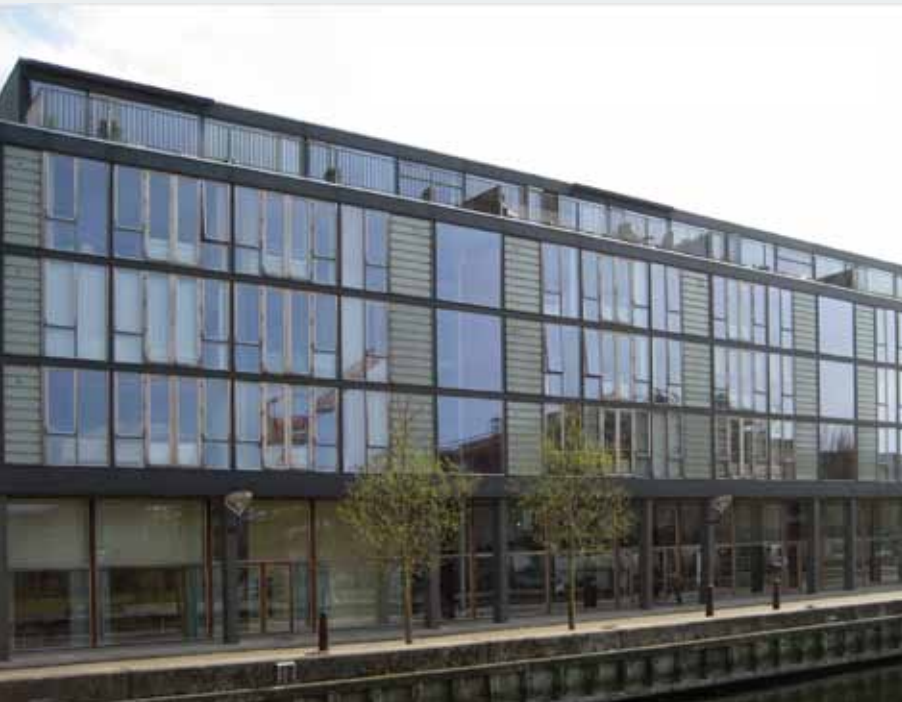
Byggeri med vinduer og døre udført i jatobatræ – og med udsat beliggenhed.
