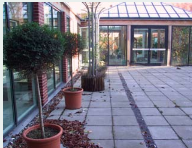
Tagterrasse med stenrende langs facade samt flisebelægning på grus
