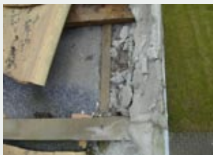
Murede gavle uden udhæng skal have bagmur
