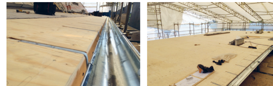
Etablering af ny tagbelægning med nedsænkede rendejern og tagrender.
