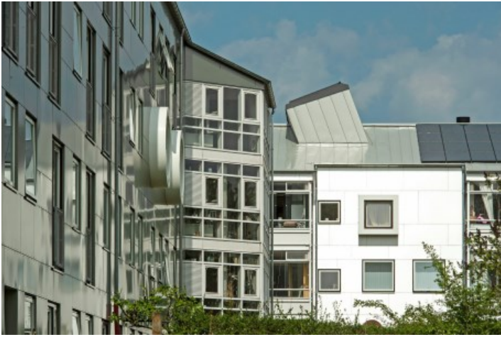
Sårbare facadematerialer, store vindues partier uden konstruktiv beskyttelse. Sandsynlighed for krævende drift. Egedalsvænge, Kokkedal, Boligforeningen 3B, Rubow Arkitekter.
