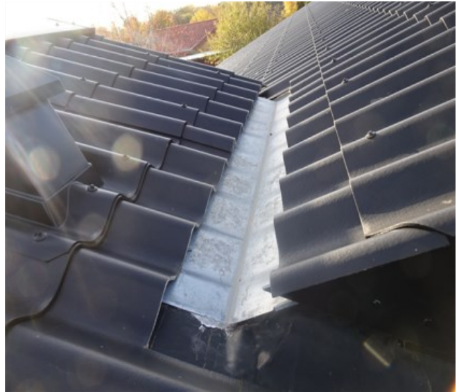
Driftseksempel: SKOTRENDE mellem to tagflader. Skotrender skal efterses og driftes jævnligt.
