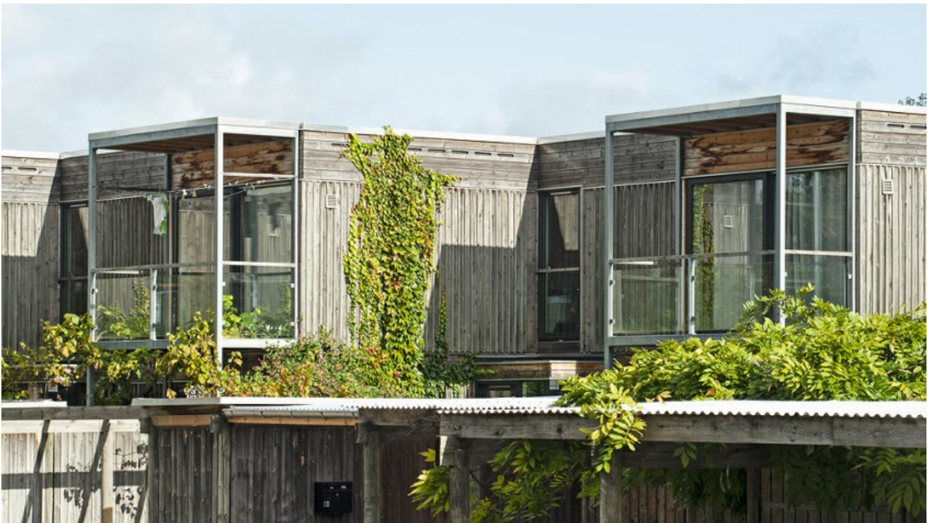
Klimaskærm i organiske materialer. Spinkel konstruktiv beskyttelse. Sandsynlighed for krævende drift. Sortemosen, Herlev, Boligselskabet Sortemosen, Rambøll Arkitektur.
