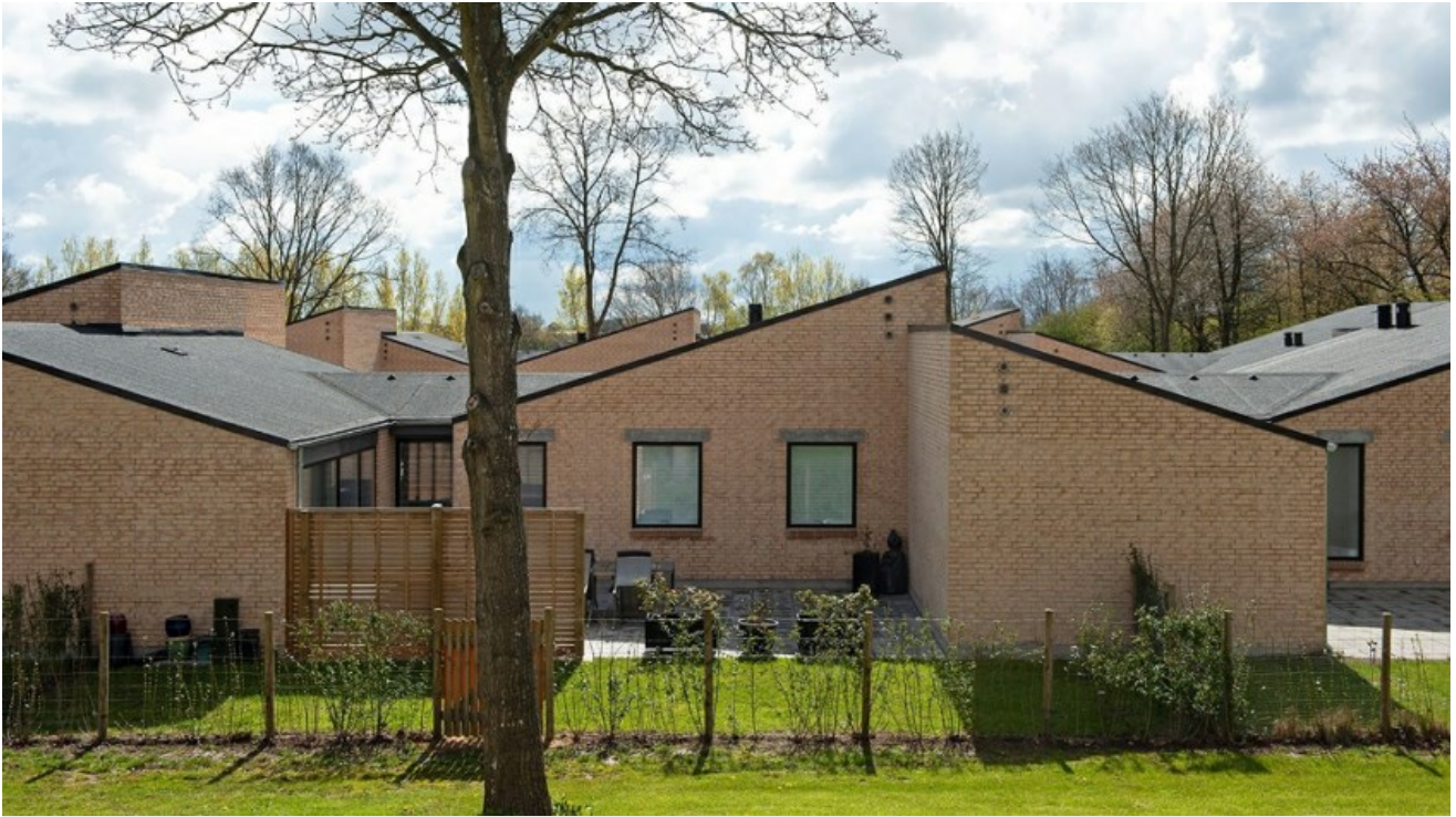
Enkle bygningsformer, få gennemføringer i tagflader, velbeskyttede vinduer. Mulighed for enkel drift. Præstehaven, Jyderup Vestsjællands Almene Boligselskab Kullegaard.
